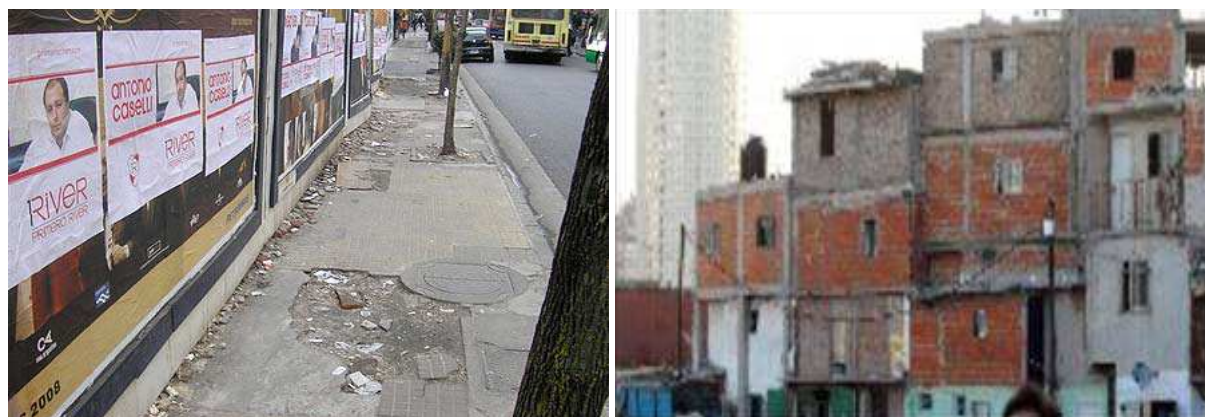
Falta de control y de cumplimiento de normativas: por irresponsabilidad o necesidad, aceras deterioradas por una obra aledaña y edificaciones precarias en una villa fuera de todo reglamento de construcción.
